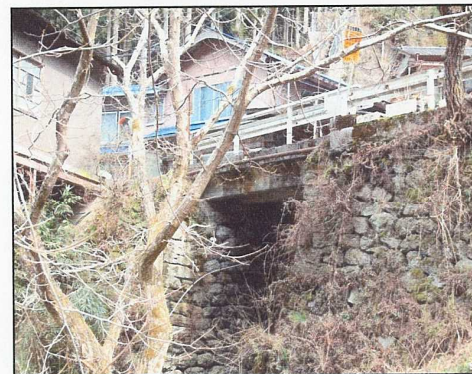
③橋梁側面 (下流側から)
